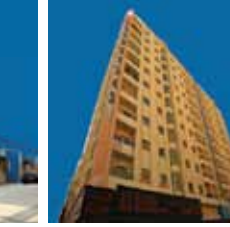
RAHMA (1) BUILDING بناية رحمة (١)
