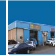
SHEDS (48 Sheds) الشبرات (٤٨ شبرة)
