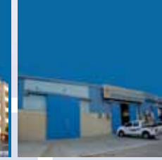
SHEDS (16 Sheds) الشبرات (١٦ شبرة)
