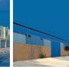
SHEDS (24 Sheds) الشبرات (٢٤ شبرة)
