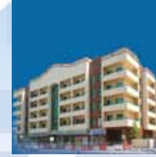
AL JAWHARA BUILDING بناية الجوهرة
