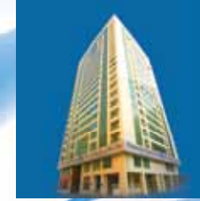
DHUBIAN TOWER برج ظبيان
