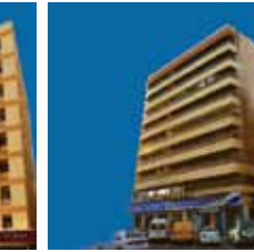
AL ZAHRA'A BUILDING بناية الزهراء
